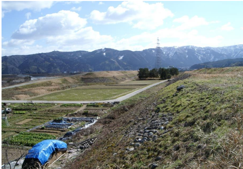
霞堤の切間の水防林（左）と霞堤の堤内地の水防林（右）
