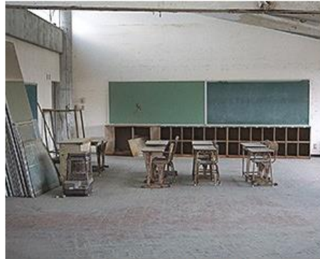
震災後、手つかずのままとなっている大川小学校の教室
