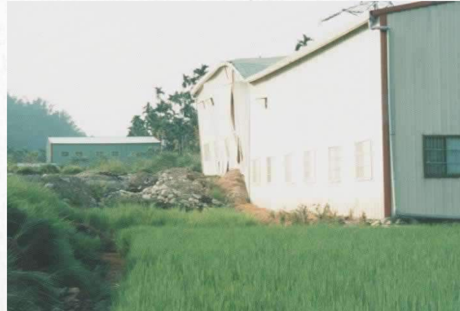
集集地震で生じた地表変位によって食い違った倉庫 https://www.oyo.co.jp/report/taiwan/photo/katudan.html
