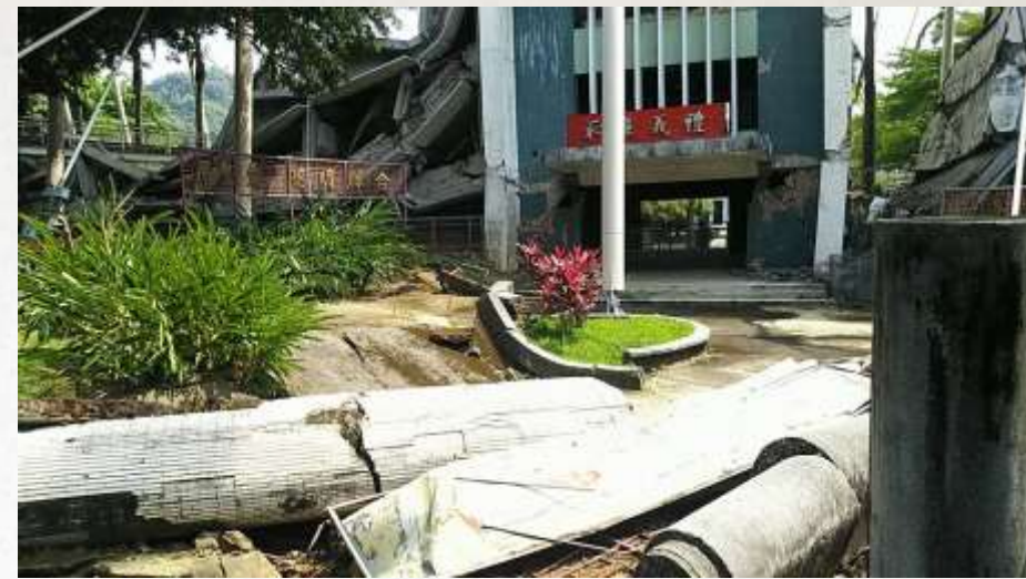
集集地震で生じた地表変位によって倒壊した光復中学校 現在は921地震教育園として保存されている（青木撮影）
