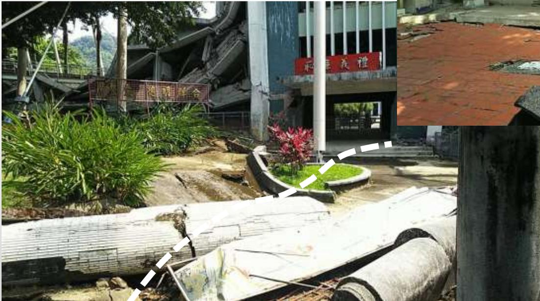
校舎やグラウンドの真下を活断層が通っていて、地震発生時に変位（段差）が生じたため、上の構造物が破壊された。
